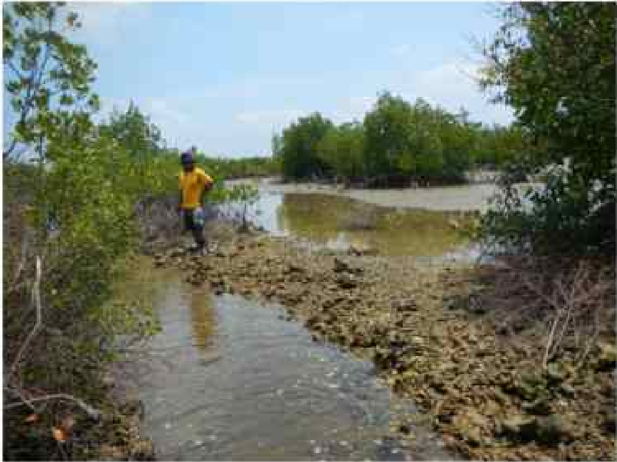
Gambar 5.18. Gangguan hidrologi - Meskipun dinding tanggul ini diratakan sejak rehabilitasi awal, masih cukup tinggi untuk menghalangi drainase kolam (background) ke sungai pasang surut (foreground). Setelah mengidentifikasi gangguan hidrologi lanjutan selama pemantauan, rencana untuk meningkatkan drainase perlu dilakukan sebagai bagian dari koreksi tengah jalan (mid-term correction).
