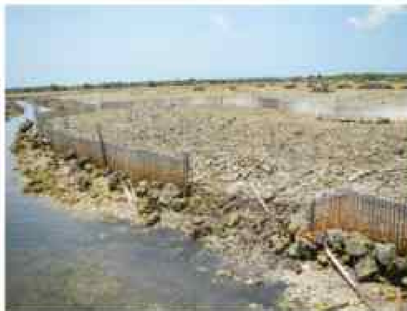
Gambar 8.14. Area gundukan (dinaikkan 20 cm dari dasar kolam) dengan pagar bamboo sementara di sebelah aliran pasang surut buatan. Tompotana, South Sulawesi, Indonesia
