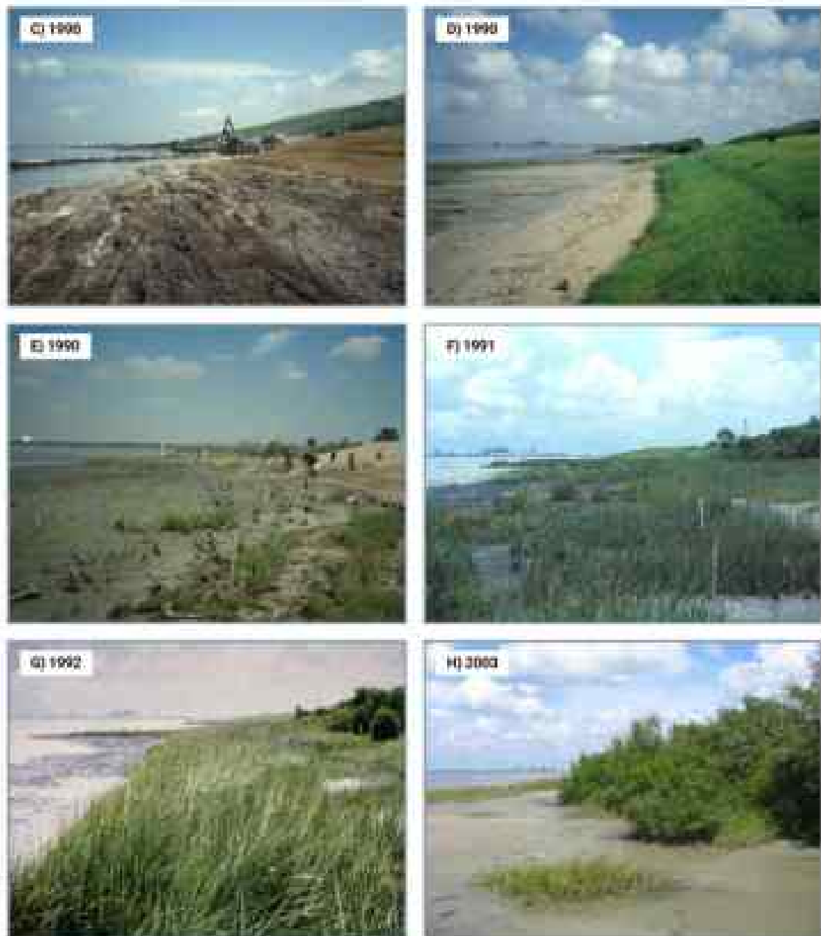
Gambar 8.29. Tepian erosi vertikal di lokasi tersebut menunjukkan erosi yang parah (A-halaman sebelah). Tepi erosi dipotong dan digradasi ulang untuk membuat tanjakan yang stabil (B-C). rumput terrestrial ditanam untuk menahan tanah bagian atas, diikuti dengan rumput halus bertoleransi laut yang menstabilkan substrat intertidal (D-G). 13 tahun setelah diintervensi, mangrove terlihat, tanda suksesnya rumput bertoleransi laut, erosi garis pantai di lokasi ini bukan masalah lagi.
