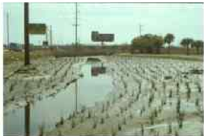
Gambar 8.12. Penempatan layar kekeruhan untuk mengatasi resiko keluarnya sedimen ke laut/ mengganggu terumbu karang/ dasar rumput laut selama proses konstruksi berlangsung (kiri). Menanam rumput spartina untuk menahan regradasi substrat tetap ditempat (kanan atas)
