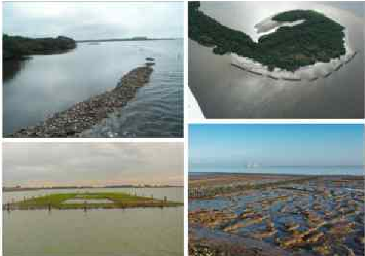
Gambar 8.12. Penempatan layar kekeruhan untuk mengatasi resiko keluarnya sedimen ke laut/ mengganggu tumbuhnya karang/ dasar rumput laut selama proses konstruksi berlangsung (kiri). Menanam rumput spartina untuk menahan degradasi substrat tetap ditempat (kanan atas)
